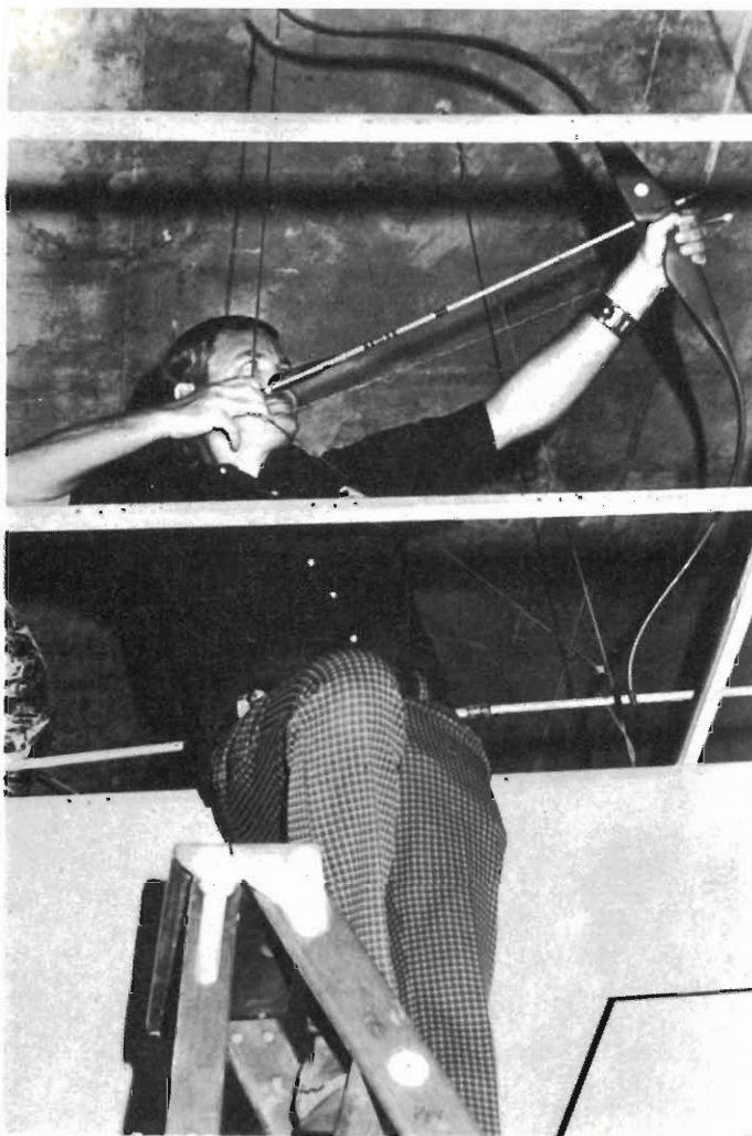
Fig. 7 - Un nuovo binomio: tiro ad arco e telecomunicazioni. Questa signora della GTE si serve dell'arco, con relativa freccia, per far sorvolare un ostacolo ad un cavo telegrafico.
